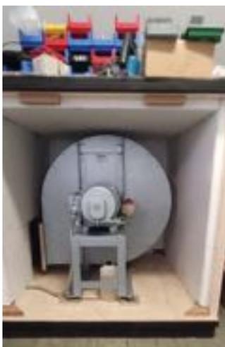
Dies ist die Windmaschine. Sie steht im Technikraum der Empore. Der Kasten wird – auch aus akustischen Gründen – zugeschraubt, so dass diese Innenansicht nicht mehr möglich ist.
